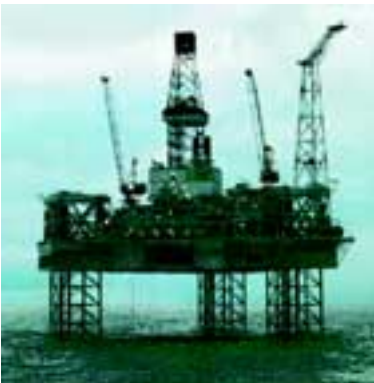
Descenso de las patas de apoyo de plataforma petrolífera
